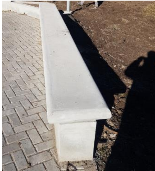
Banco corrido de mampostería revocado
